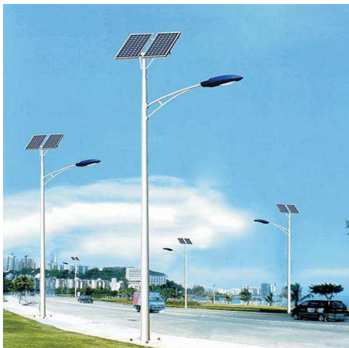
Ryc. 37 System oświetlenia ulicznego wykonanego z opraw LED zasilanych energią elektryczną z paneli fotowoltaicznych źródło ELGO Gostynin
