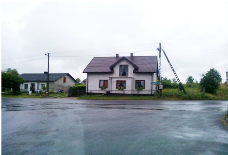
Ryc. 18 Wieś Brzuze - fragment linii energetycznej nn z oprawą oświetlenia produkowaną w latach 70 – 80-tych XXw
