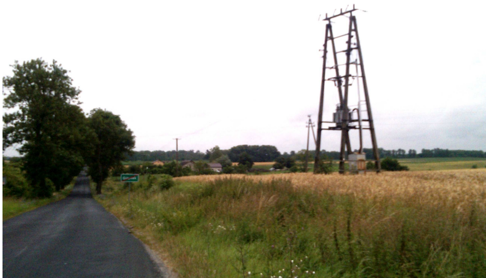
Ryc. 16 Stacja transformatorowa 15/0,4KV typu STS 20/250 na pograniczu miejscowości Giżynek pamiętająca lata 60-te XXw
