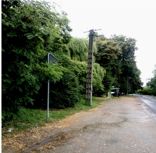
Ryc. 17 Fragment linii energetyczno – oświetleniowej nN na słupach typu „DANA” pamiętających lata 60-te XXw. z energochłonnymi oprawami rtęciowymi
