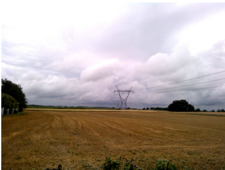
Ryc. 21 Zmodernizowana linia przesyłowa 400kV na terenie Gminy Brzuze
